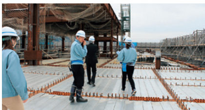
屋上です。板の下は...
