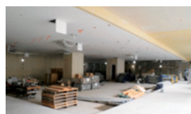
1階アメニティーエリア 現状
