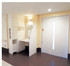
病棟内の4床室前
